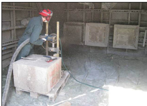
BILD 1a. Sprutning av sprutbetong.
